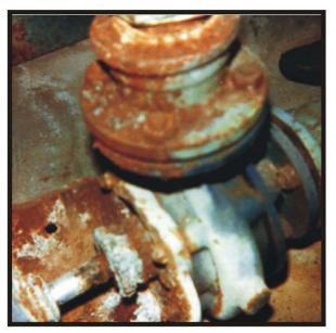
Las instalaciones de calefacción por agua caliente, tienen constantes pérdidas de agua, especialmente por las empaquetaduras de los ejes de las bombas de circulación, como así también debido a las evaporaciones y desbordes en el tanque de expansión, ocasionando ésto la penetración de gases corrosivos, especialmente oxígeno disuelto y anhidrido carbónico, causando graves peligros de corrosión en las instalaciones, como consecuencia del aporte de agua al Tanque de Expansión.
